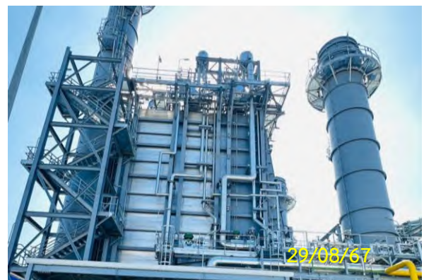
ปล่อง HRSG ของหน่วยผลิตไฟฟ้า ABP1
